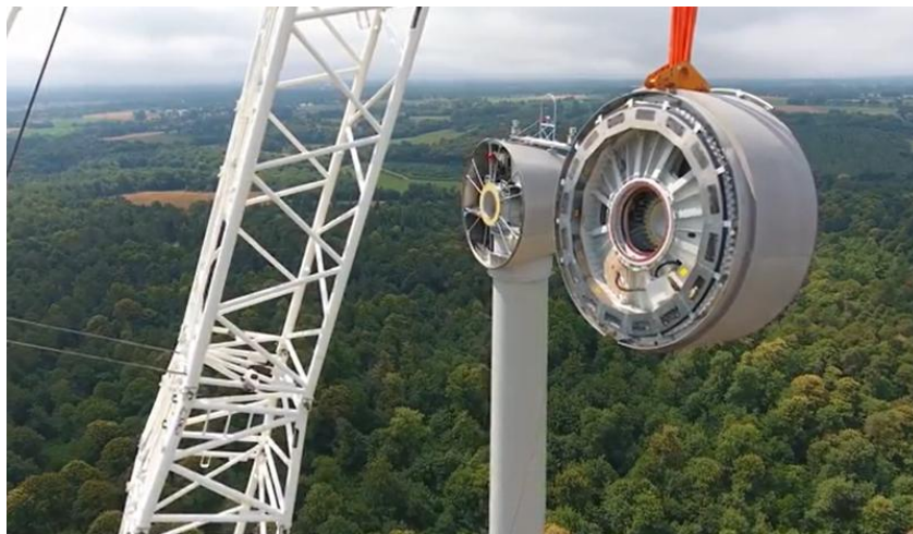
Montage du stator du parc éolien du Rocher Breton
