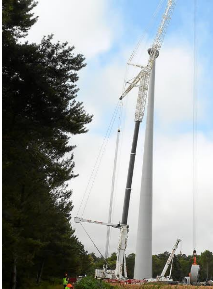
Construction du parc éolien du Rocher Breton
