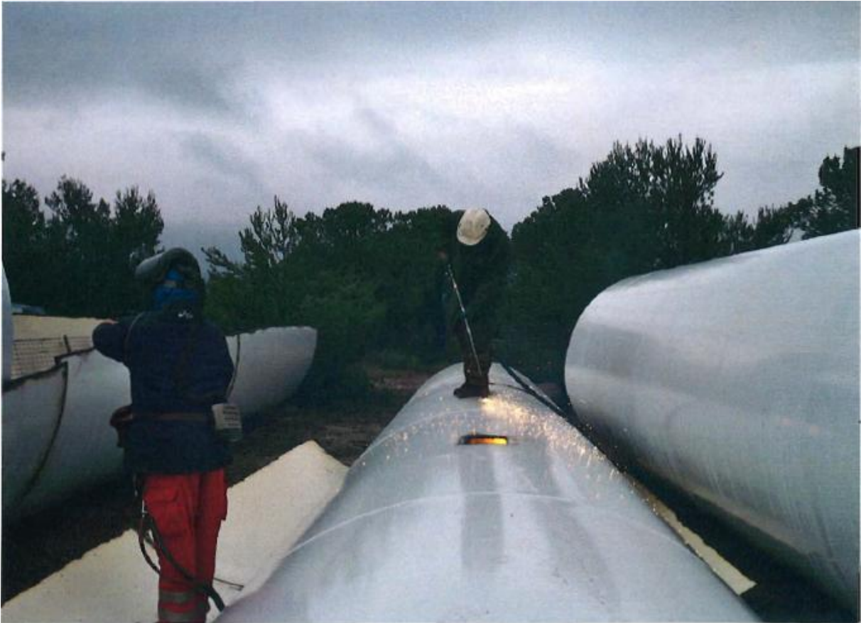
Découpe par chalumeaux des tronçons de mât
