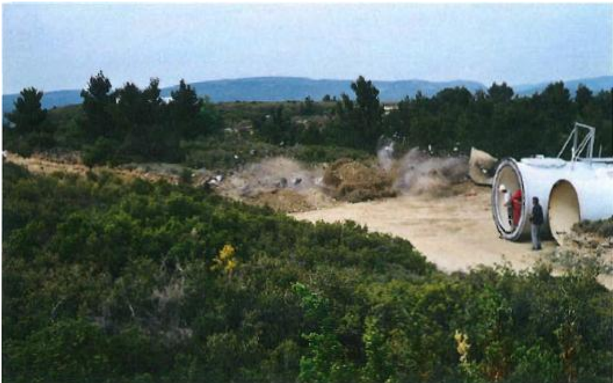
Destruction des fondations par explosifs pour évacuation puis remise en état
